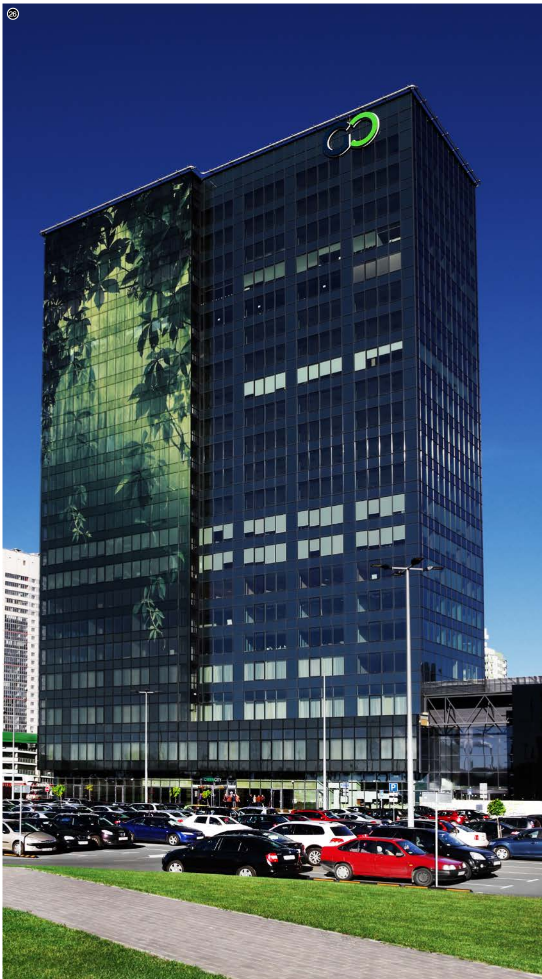
26. Бизнес-центр «Green city» ул. Притыцкого, Минск KAN-therm Press
